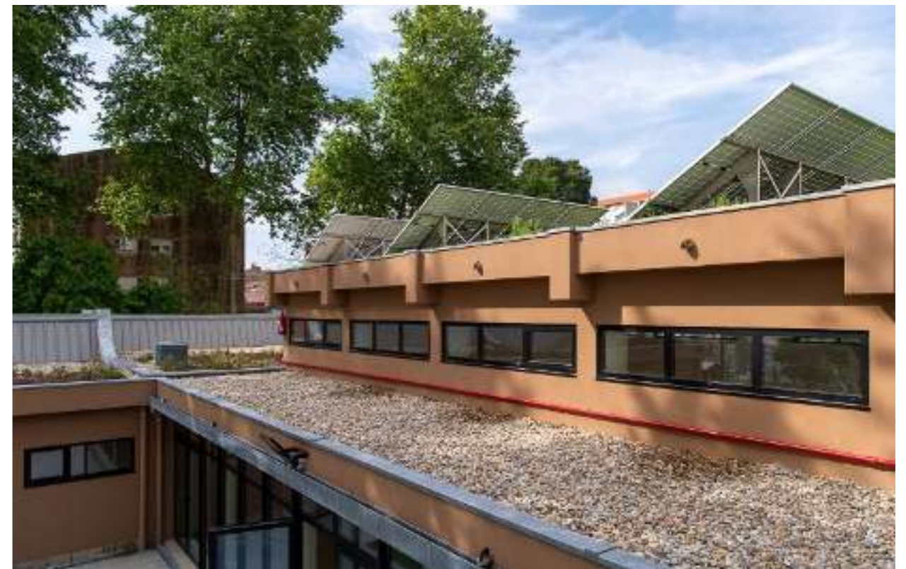
Figura 35. Sistema solar fotovoltaico na Escola Básica do Falcão.
