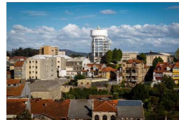
Figura 37. Estação elevatória dos Congregados.
