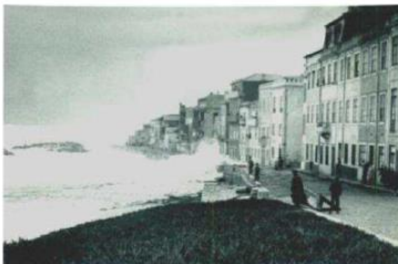
Figura 6.8.1. Praia dos Ingleses antes da elevação da cota da estrada
